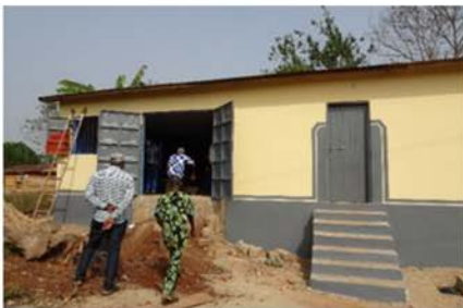
Straßenansicht des Gebäudes
